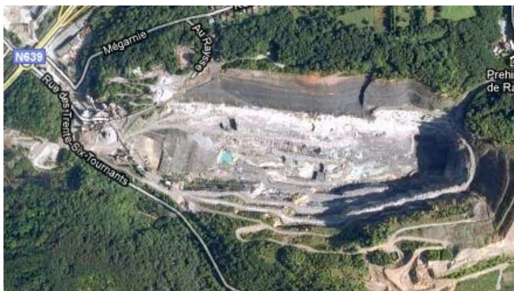
Fig. 3: vue aérienne de la mono-décharge de Prayon SA
